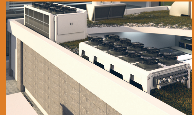
Ersatz durch EC-Axialventilatoren
