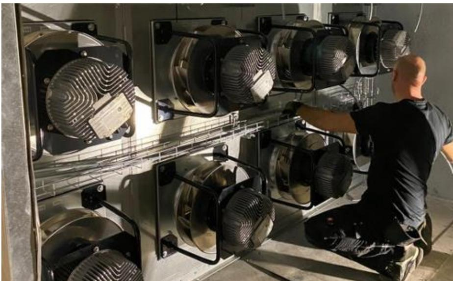
Bild 2: Im Automobilmuseum ZeitHaus reiht sich Fahrzeug an Fahrzeug. Die neue Lüftungsanlage tut es ihm nach einem Retrofit gleich: In einem FanGrid reiht sich RadiPac an RadiPac – und spart 25 % Energie ein. (Bild: ebm-papst)
