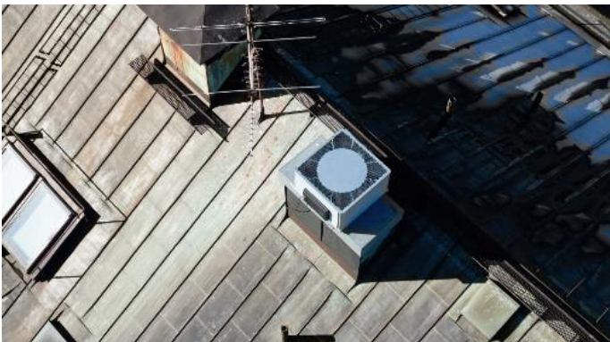
Bild 1 a + b: Via Cloud lassen sich die Daten des Lüftungssystems live monitoren und auswerten.
